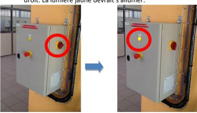
2. Mettre la seconde armoire sous tension. Le bouton est situé, là encore, à droite de l'armoire. Une lampe jaune doit s'allumer.
