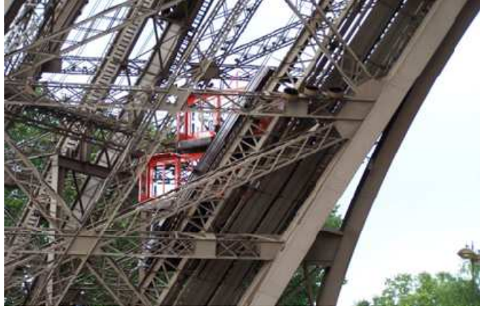
Figure 1 : chariot tracteur supportant les deux cabines de l'ascenseur du pilier nord de la tour Eiffel
