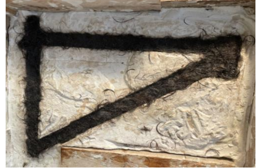
2) Confection du cadre à base d'un mélange de cheveux et de résine époxy
