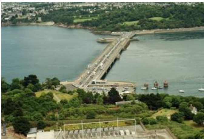
Figure 34 : Usine marémotrice de la Rance, source Conseil régional de Bretagne, et l'un des 24 groupes bulbes de 10 MW, source EDF
